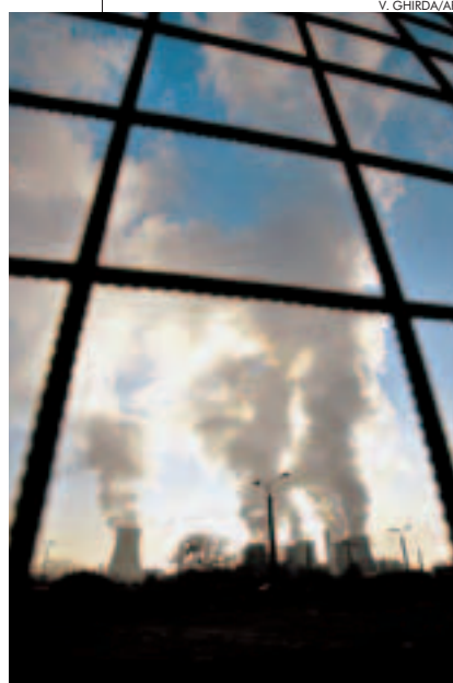
Le enormi ciminiere di una centrale termica a Bucarest. Nelle due foto a destra, dall'alto: la libreria e il negozio di abbigliamento presenti all'interno della sede del Polo Bonfanti. Nella pagina seguente: stand di prodotti biologici alla "Festa dell'altra economia" a Roma.
